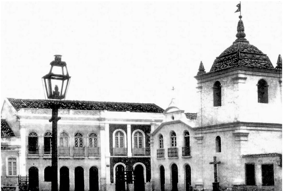
Igreja Nossa Senhora dos Remédios, com lampião à gás (querosene) na iluminação pública da cidade
